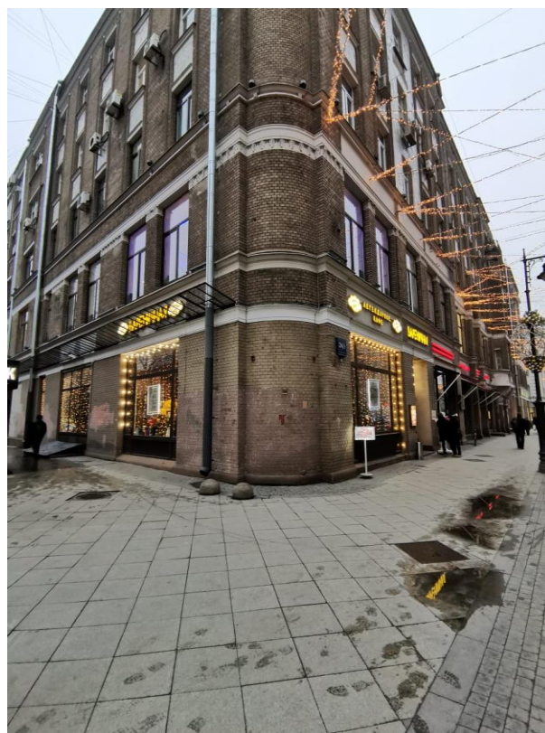
Фото № 4. Фасад стороны улицы
